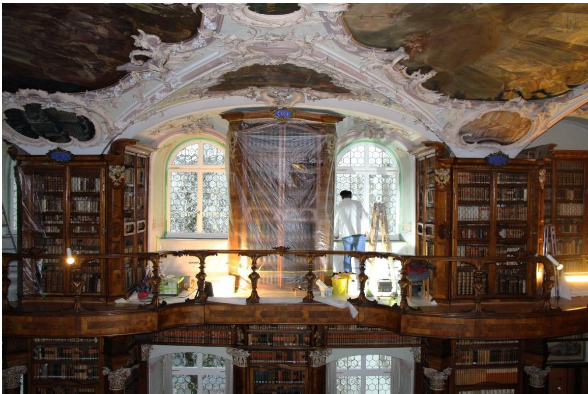
Fenstereinbau im Barocksaal, 2. Dezember 2020 (Foto: Silvio Frigg).
