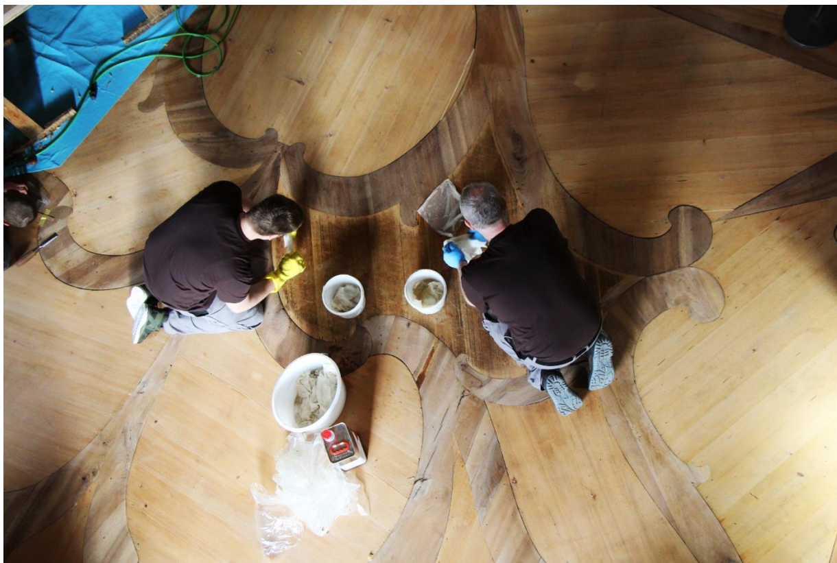
Oberflächenspezialisten reinigen den Original-Holzboden der Stiftsbibliothek (Rottanne, Nussbaum, Kirschbaum). (Foto: Silvio Frigg)
